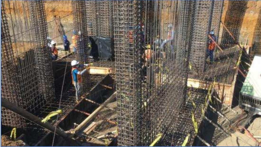
Armado de acero de refuerzo estructural para fundaciones, pedestales y columnas.
