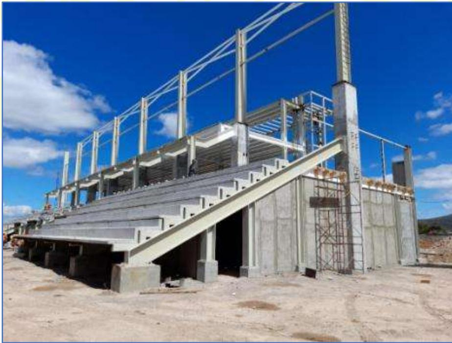
FOTO #1. GRADERIAS. Instalación de graderías de concreto con un avance del 80%.
