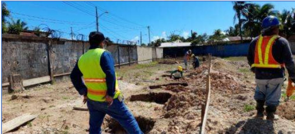
Realizando excavación estructural para las fundaciones de la graderías sol en la línea de tercera base.
