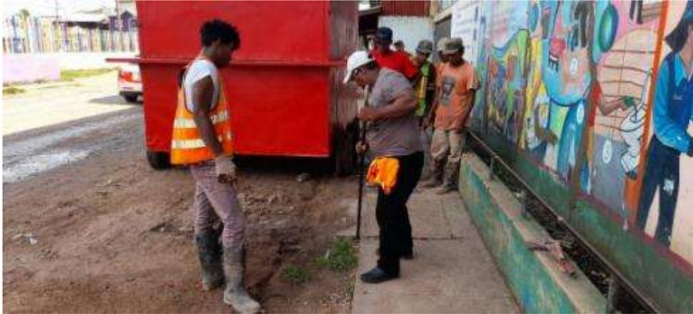
Realizando sondeo y búsqueda de la entrada de agua potable, para conectarse al sistema nuevo.
