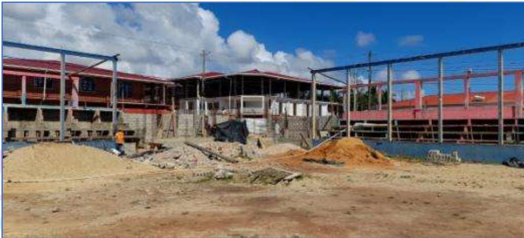
Panorámica del área central del estadio, mostrando lavantamiento de paredes e instalación del acero de refuerzo de columnas de concreto.
