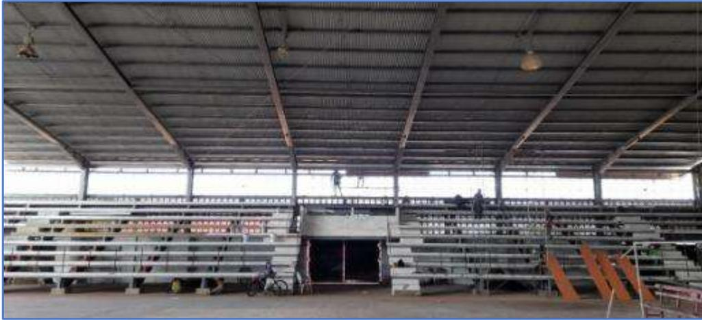
Fotos mostrando la estructura de techo pintada y la cubierta de techo nueva instalada.
