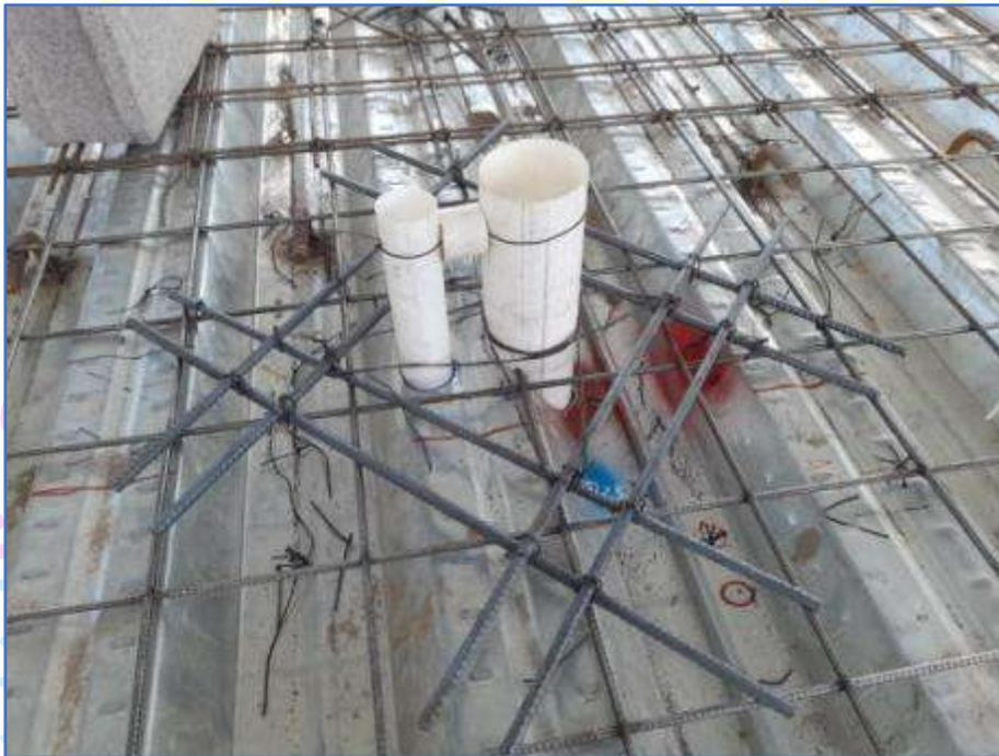
FOTO #3. Detalle de reforzamiento con hierro corrugado # 3 en unión tubería pvc con losa.
